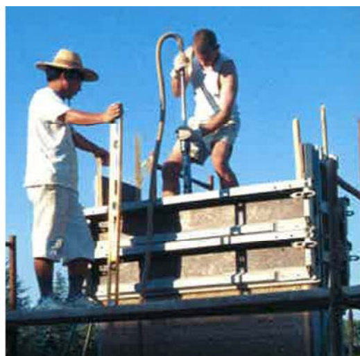
写真 2.0.2 古来より伝わる版築工法の様子 2
