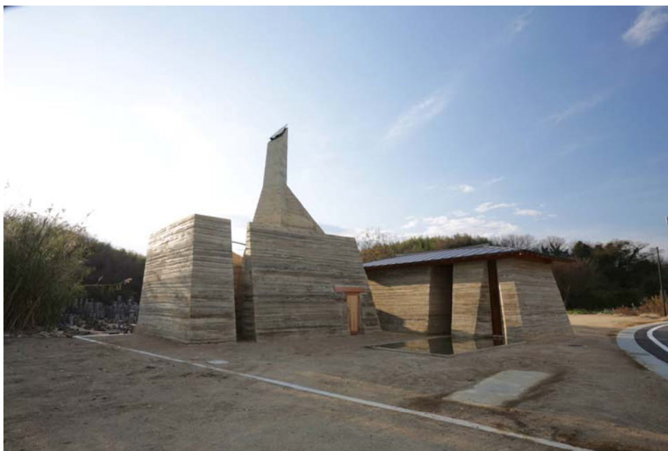
写真 1.1.1 本島プロジェクト全景（北東より望む）
