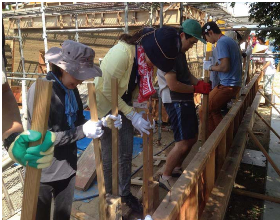
写真 2.0.3 女性による施工の様子
