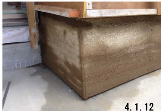
写真 4.1.6 ラスに 70 mmの施工
