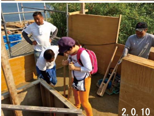
写真 2.0.4 型枠の設置
