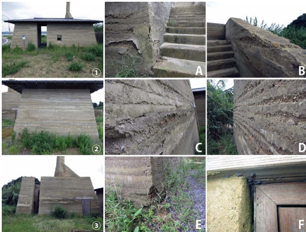
写真 2. 3. 1 竣工から 5 年後の風雨・虫害被害の様子 (① ~③ : 全体、A~F : 詳細)
