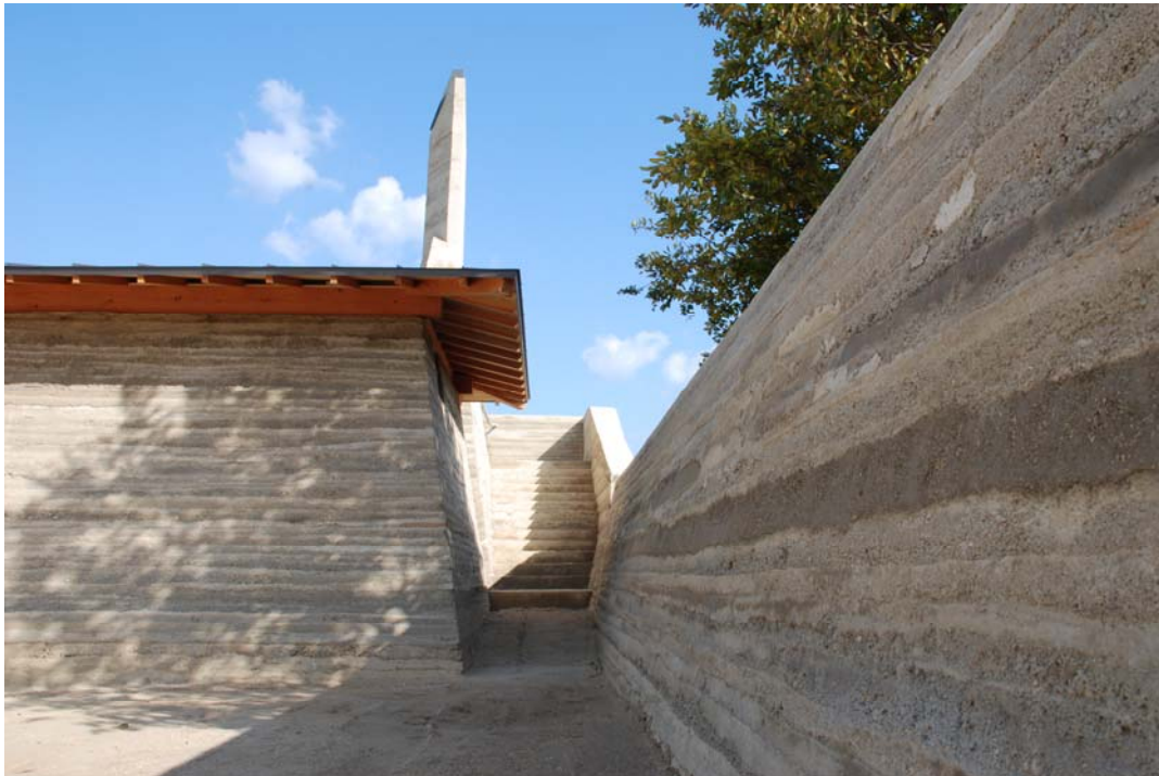
写真 1.1.3 西側より見る
