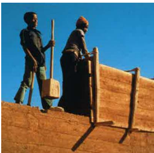
写真 2.0.1 古来より伝わる版築工法の様子 1
