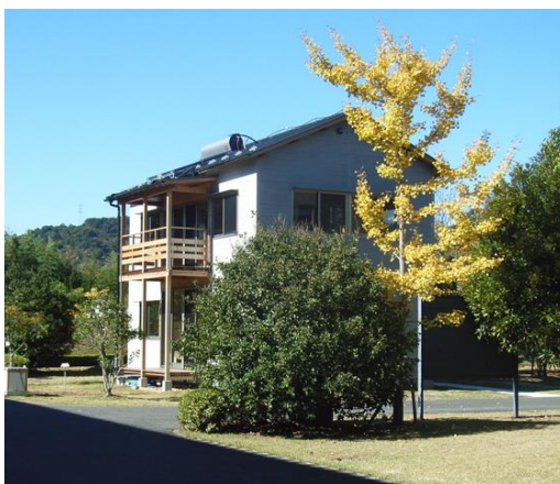
環境共生型木造実験住宅
