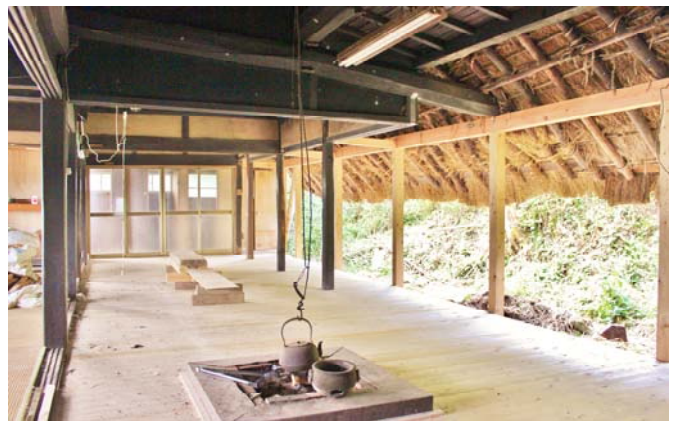
写真 4 改修後配置写真
