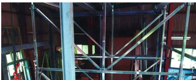
図 2 トラス構造の耐震吊り天井
