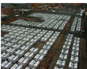
x) サイレントボイドシステム xi) 波型のボイド型枠
