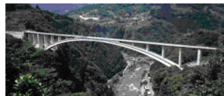
図 6 宮崎県天翔大橋
