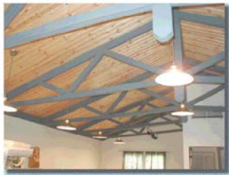
屋根形トラス構造
