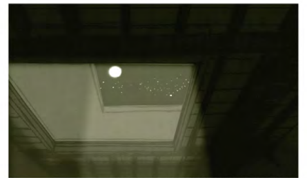
■螺旋の外周部の窓と内周部の窓が関係し、広い空間にコントラストが生まれる
