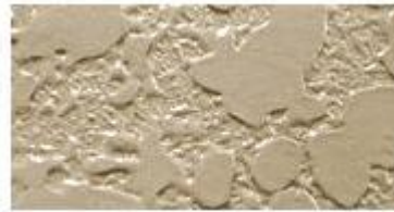
吹付タイル凸部処理仕上
