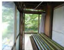
縁側に沿ったガラス戸は民家建設後に設置されたと思われる
