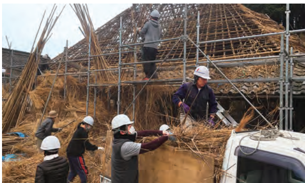
学生も加わって茅はがしと屋根の解体を行った
