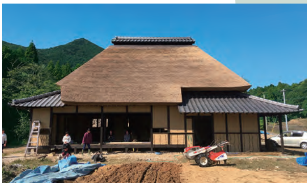
移築された古民家
