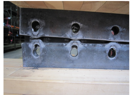
鋼板縁端破断
