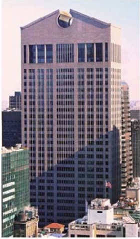
AT&Tビル (フィリップ・ジョンソン)
