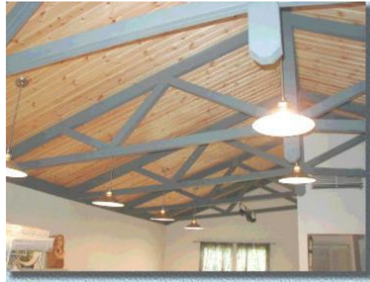
屋根形トラス構造
