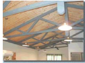
屋根形トラス構造
