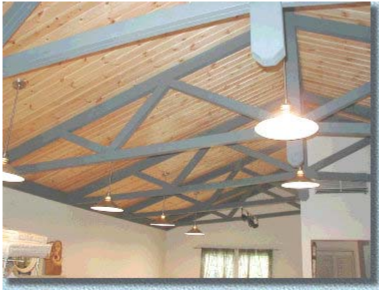
屋根形トラス構造
